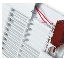
Wentylator nie pracuje – żaluzja jest zamknięta
